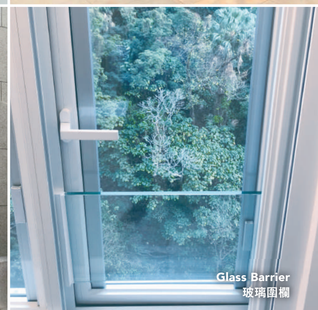
Glass Railing 欄河工程
